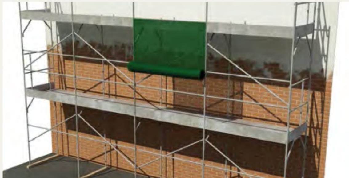
2 - Procedere con il fissaggio tramite fascette o filo di ferro, sfruttando l'occhiellatura o le asole.
